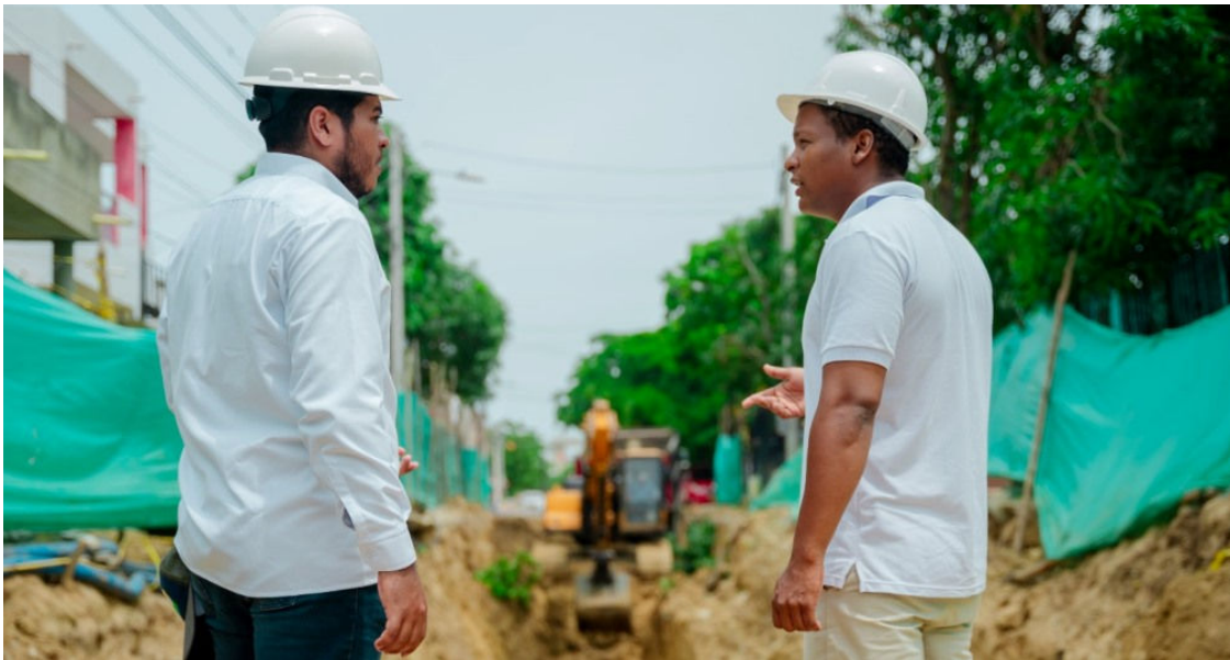
Funcionarios de la empresa Aqualia y la empresa contratista inspeccionando la obra de la calle 27 barrio Los Olivos.
