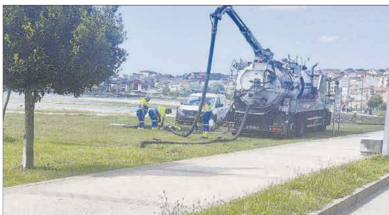
Trabajos de Aqualia en una arqueta de la Avenida da Xunqueira. // FdV
